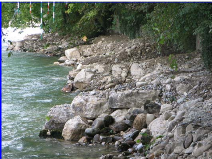
Ufervorschüttung und Buhnen am Badener Ufer
