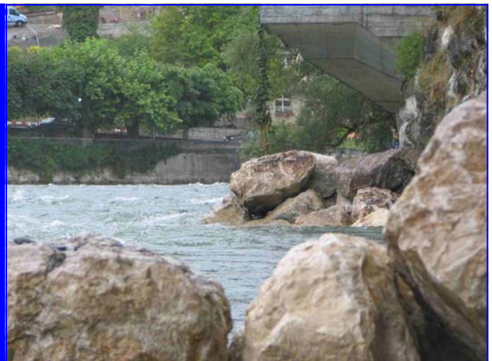
Buhnen aus grossen Kalkblöcken unterhalb der Bädergarage
