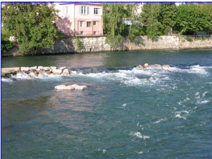
Oederlin Wehrkopfsanierung mit 2 Steinblockgruppen zur besseren Strukturierung für den Kanusport
